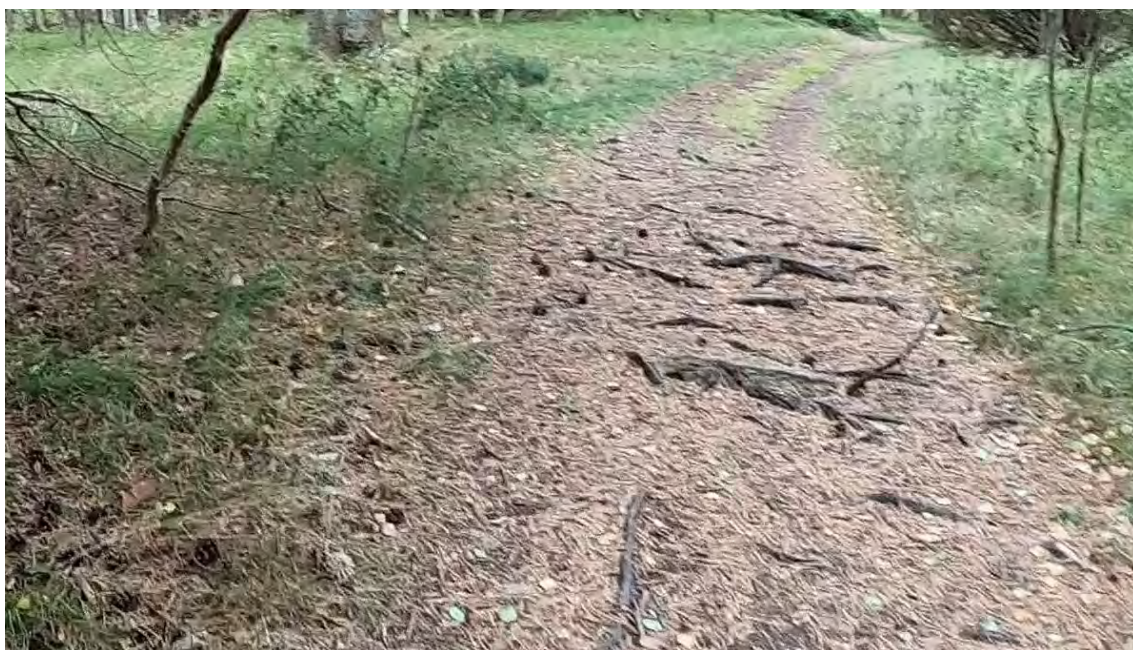
Figur 4: Tid: 00:26 Eksempel på synlig nedslidning af stien på blød skovbund uden befæstelse
